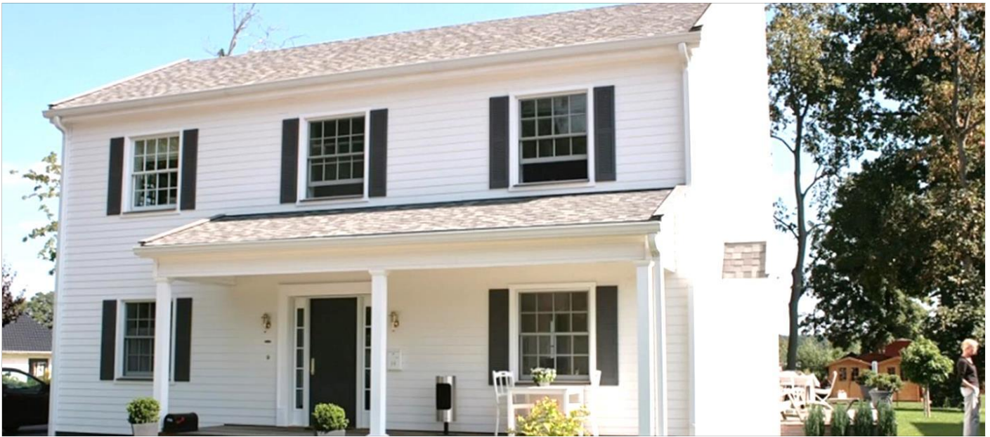
Foto: JAMES NR errichtet in Brandenburg
