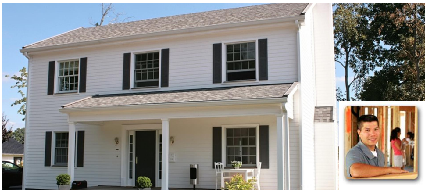
Foto: JAMES NR erbaut von TWH im Land Brandenburg
