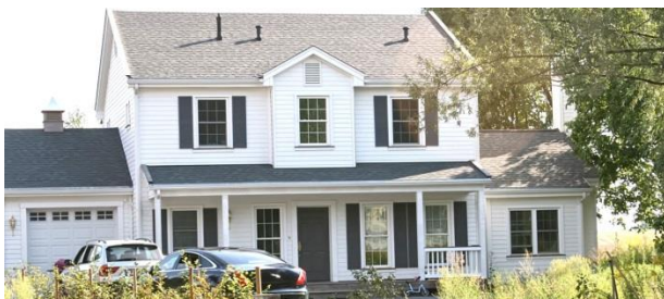
Von TWH bei Potsdam erbautes KfW-50-Haus und BRAUCH-WASSER-SOLAR-ZELLEN auf der Haus Rückseite
