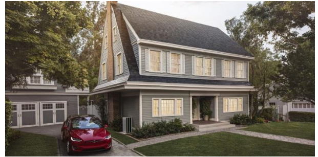
HAUS mit TESLA Solarschingles
