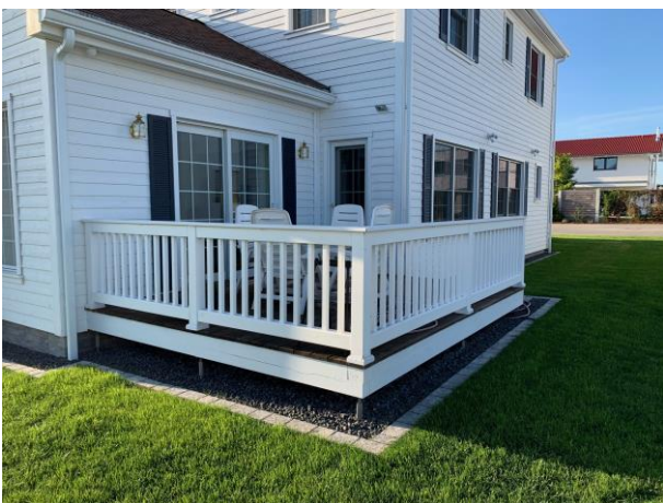
TWH Haus PILOTAGE mit weißer Dachrinne und weißem Fallrohr
