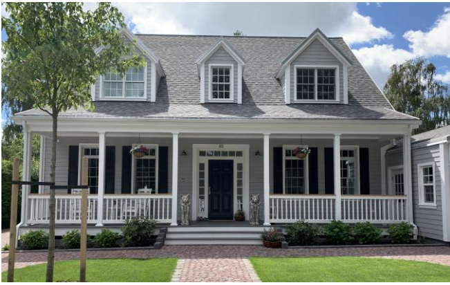
TWH Haus GEORGE V mit Schindeln & weißen Dachrinnen, Fallrohre
